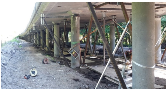
Omfattende interimskonstruktion.
