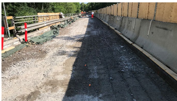
Efter fjernelse af oversidearmering.
