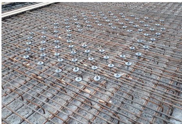
Forskydningsdorne og ny armering monteret, overside brodæk.
