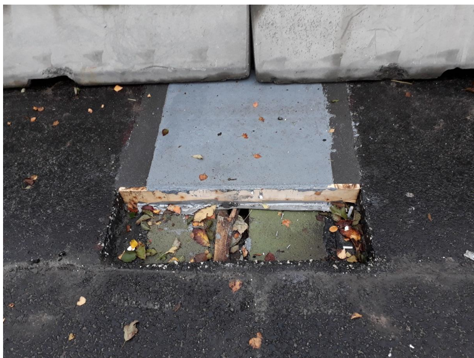
Etapeskel i fuge.
