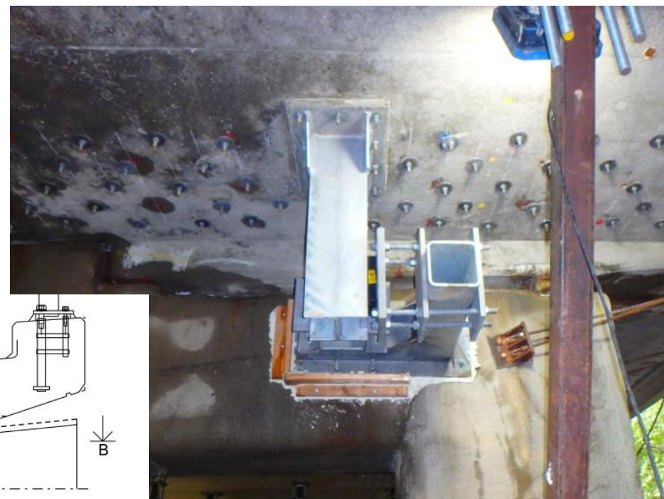
Stålkonstruktion for side- og endestyr.
