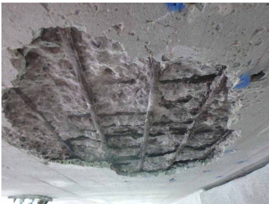
En mindre reparationen der "løber" ved behugning.
