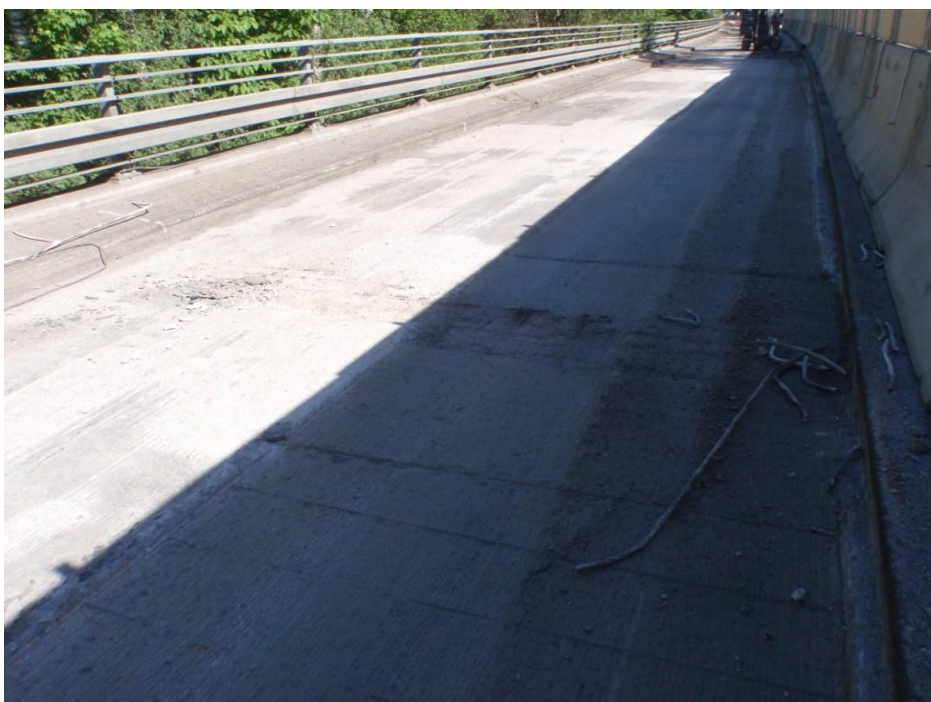
Generelt en fornuftig stand af betonen efter 1. fræsning.
