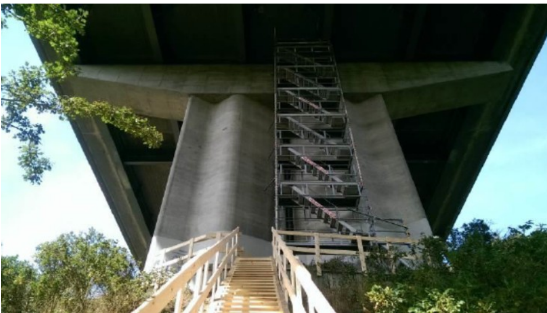
Mellemunderstøtning: adgangsforhold skabes
