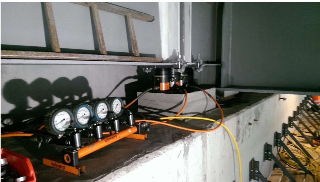
Søjletop: Løfteudstyr monteret
