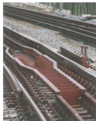
Compensatie-inrichting IJsselbrug, Zwolle.
