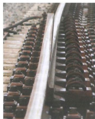
Detail tong en aanslagspoorstaaf.
