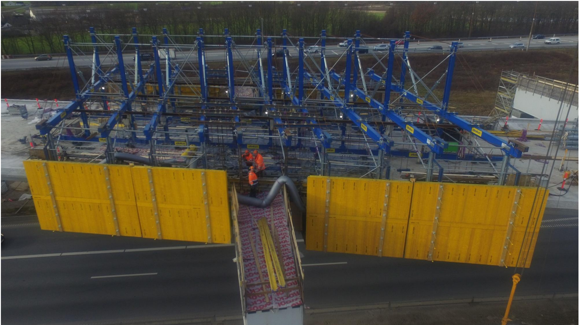
Forskallingssystem over tværbjælker
