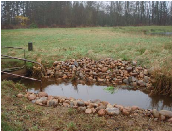
Sikring af skrånninger kan ske ved faskiner eller stenudlægning
