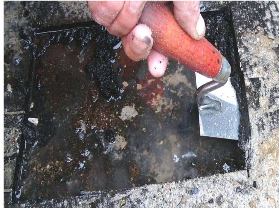
Skadet: Løs + frit vand
