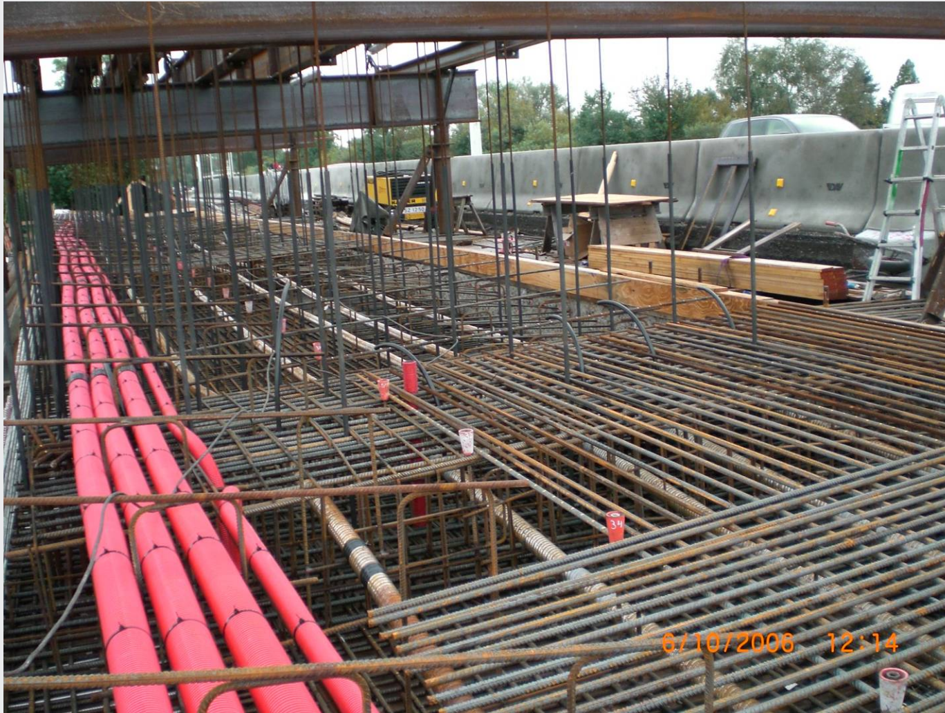
M3 Bro 55.00 UF Slotsherrensvej Overarmering pågår
