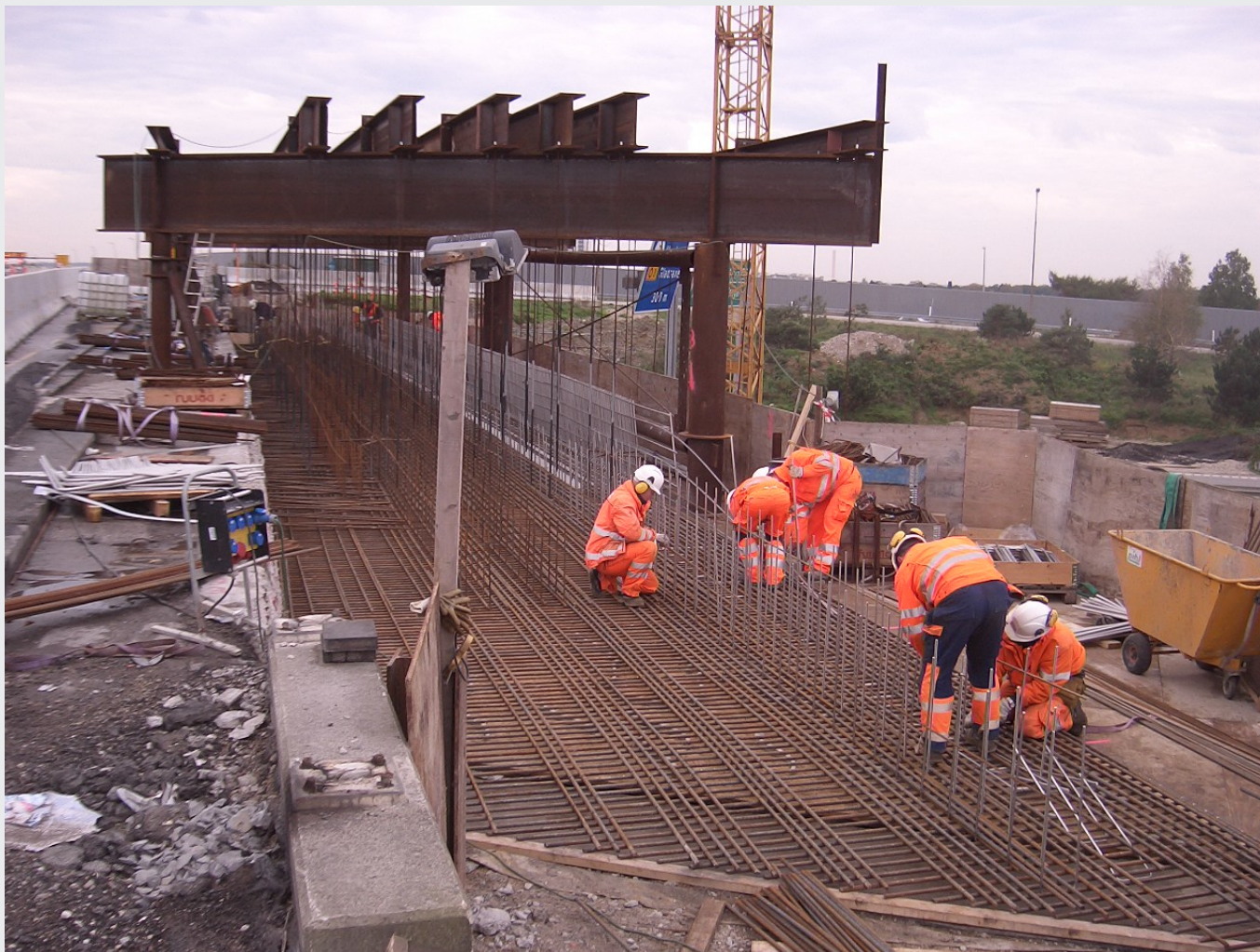
M3 Bro 29.00 UF Hillerødmotorvejen Kantbjælkearmering pågår
