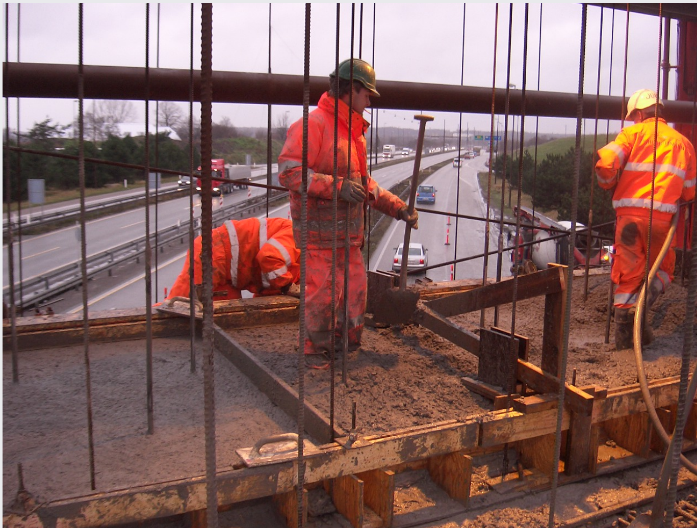
M3 Bro 29.00 UF Hillerødmotorvejen Støbning – i decemberregn
