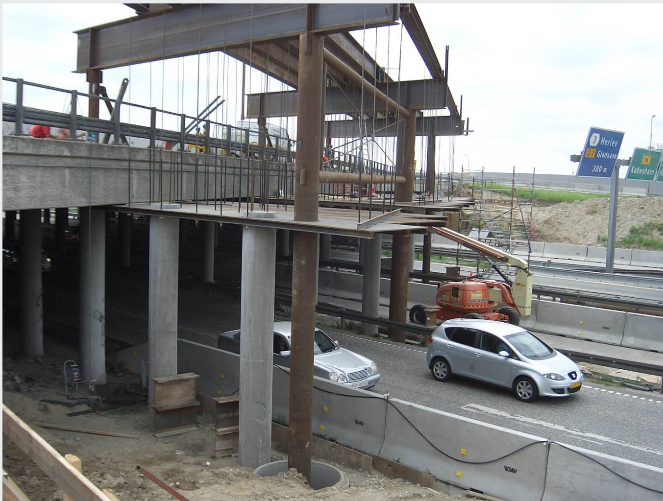
M3 Bro 29.00 UF Hillerødmotorvejen Montage af kassetter
