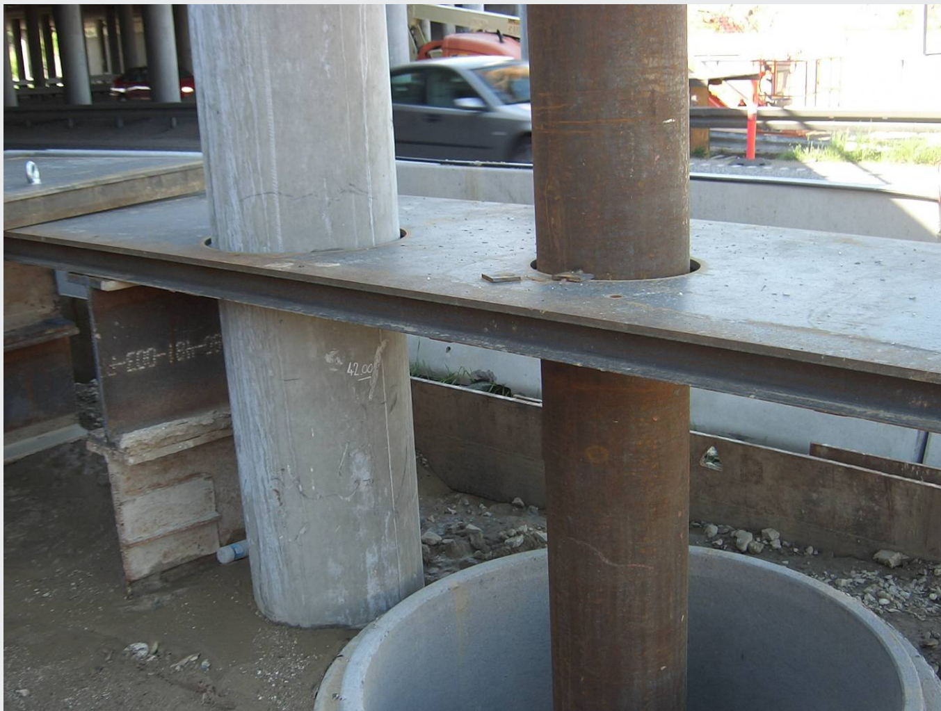
M3 Bro 29.00 UF Hillerødmotorvejen "Start-kassette" monteret på søjler
