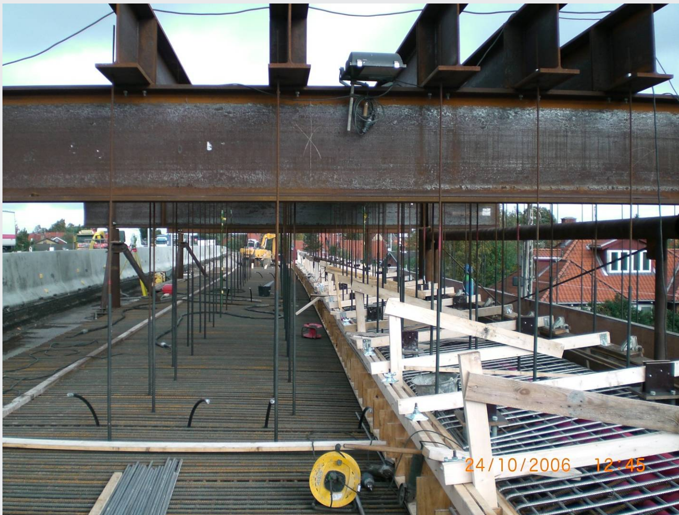
M3 Bro 55.00 UF Slotsherrensvej Klar til støbning
