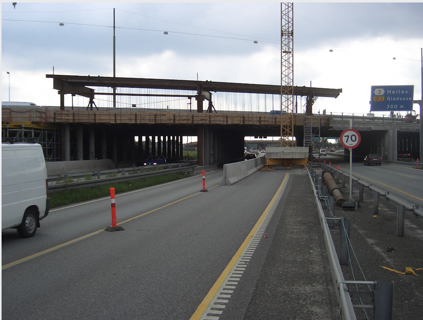
M3 Bro 29.00 UF Hillerødmotorvejen Kran opstillet, stillads klar
