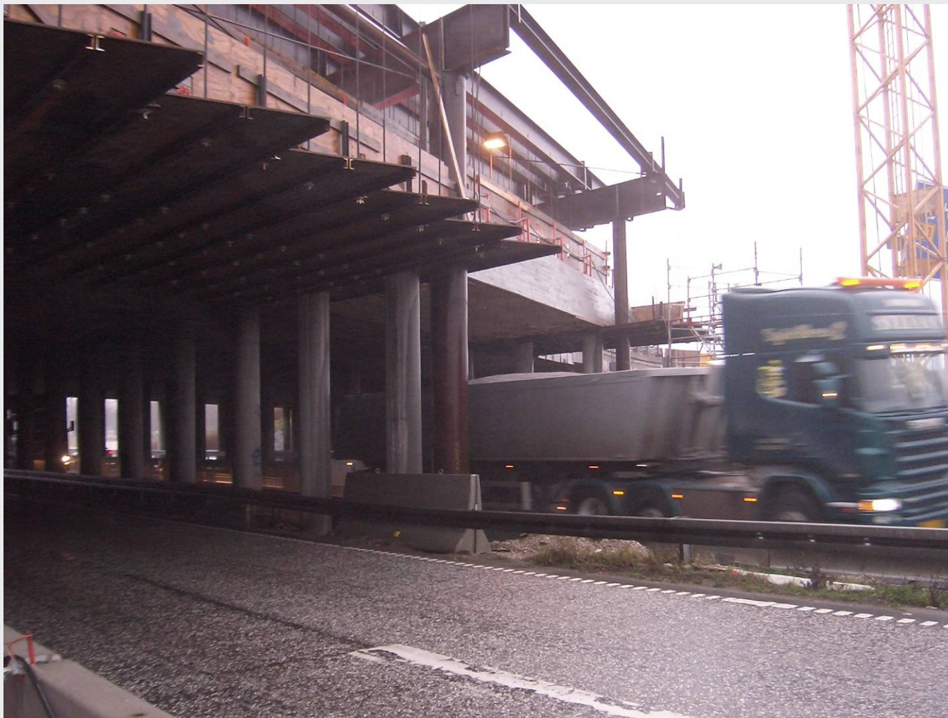
M3 Bro 29.00 UF Hillerødmotorvejen
