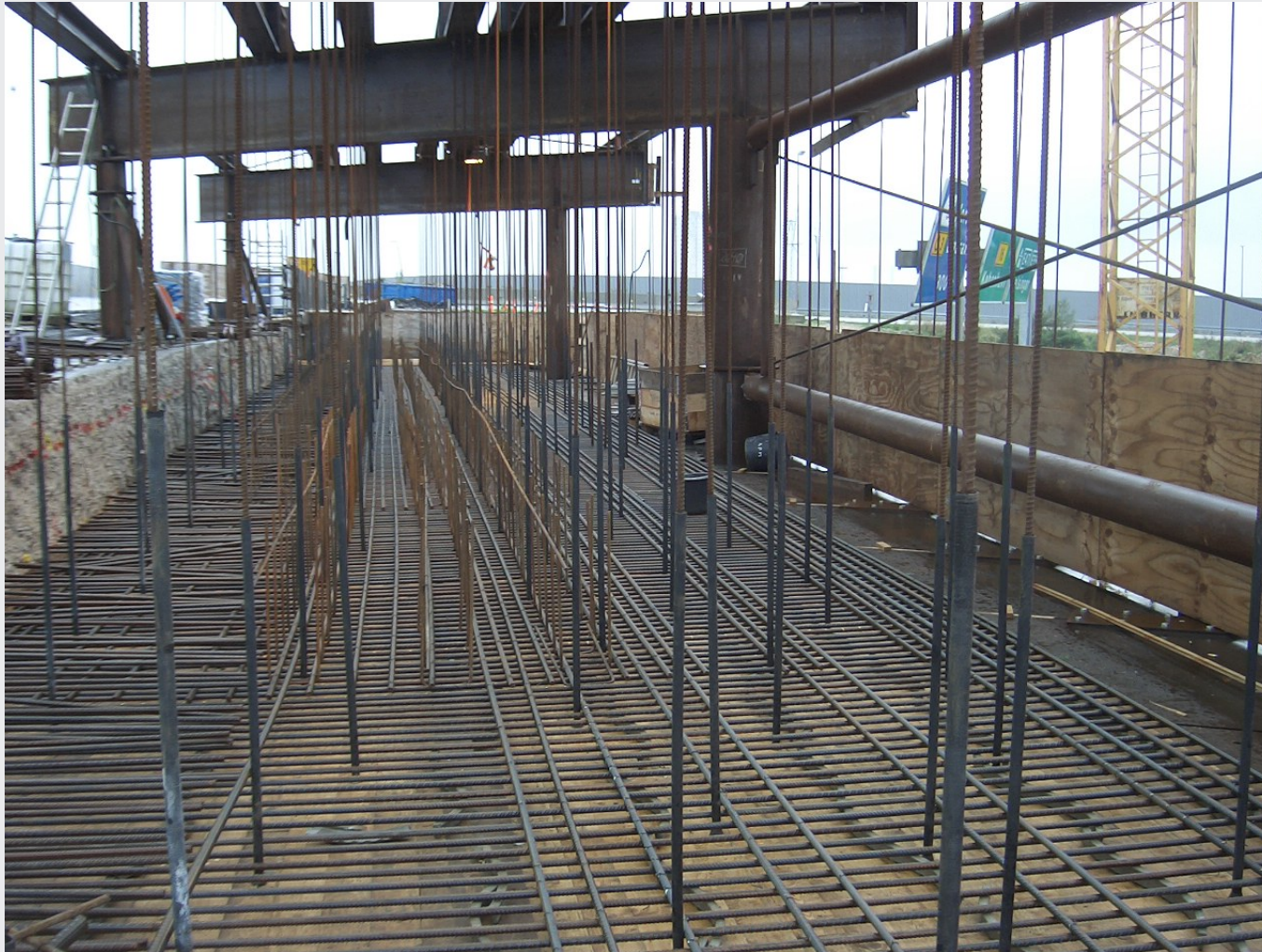
M3 Bro 29.00 UF Hillerødmotorvejen Undersidearmering pågår
