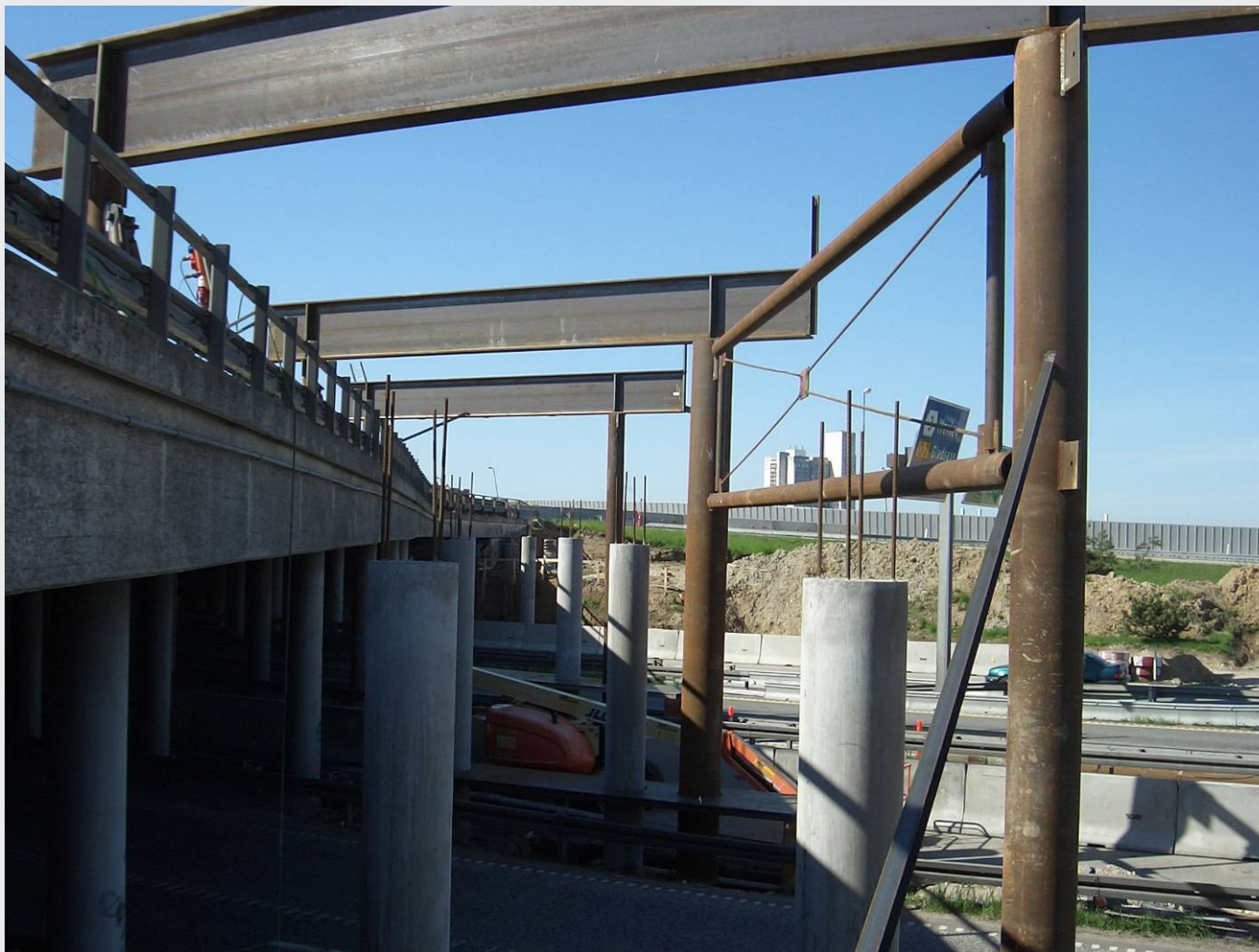
M3 Bro 29.00 UF Hillerødmotorvejen Alle rammer monteret. Afstivende kryds monteret.
