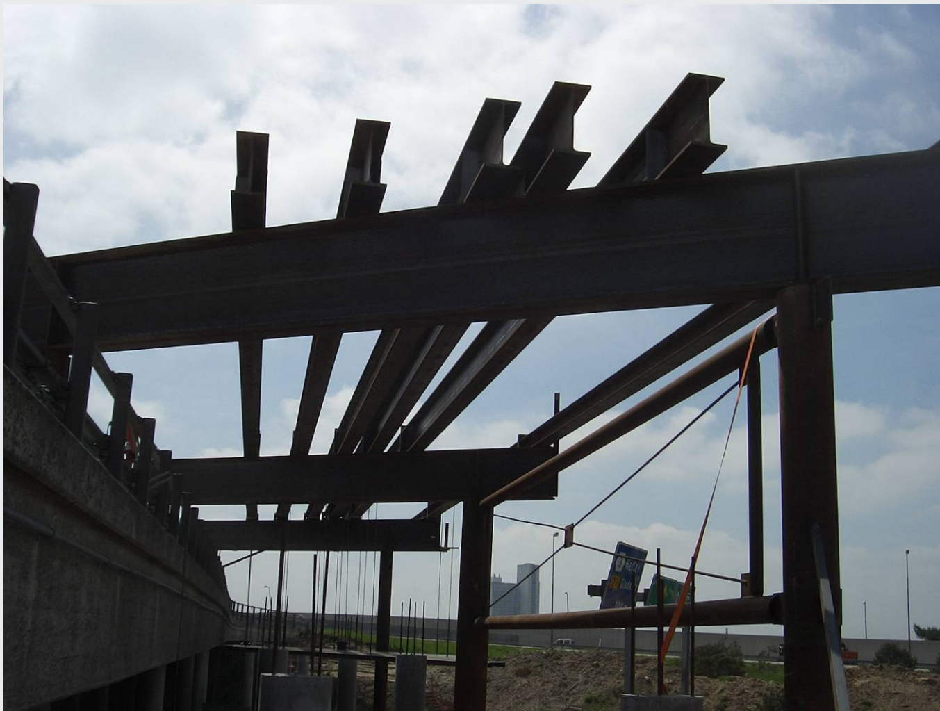
M3 Bro 29.00 UF Hillerødmotorvejen Oplægning af dragere pågår.
