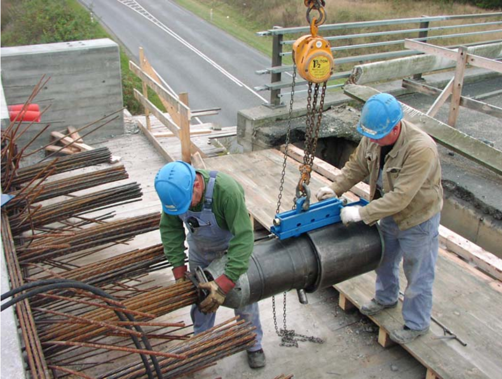
Opspænding af "intern forspænding" – 19C15. Danmark.
