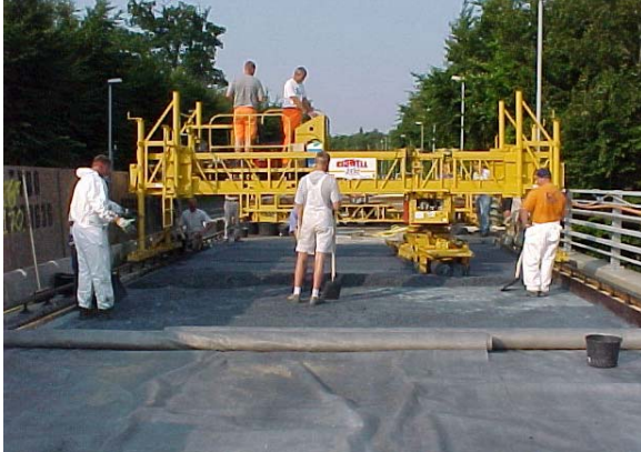
Udlægning af LMC med "concrete paver" fra USA; her på Rismarksbroen
