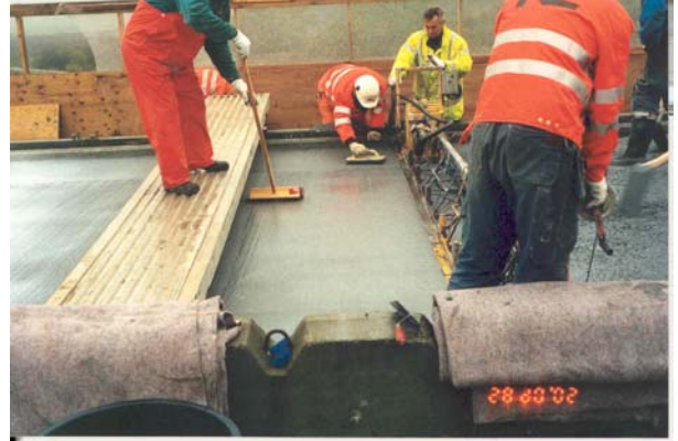
Udlægning af LMC med bjælkevibrator på Gelstedvejsbroen. Profilerung med kost.
