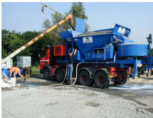
Fyldning af mobilt blandeanlæg til blanding af latexbeton. Anlægget er monteret på lastbil.
