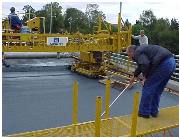
Udlægning af latexbeton med concrete paver, og efterfølgende profilering med special ”rive”.
